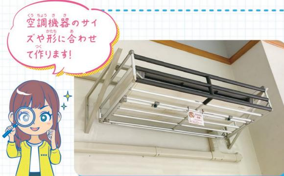
体育館の空調機器に取り付ける「防球ガード」はボールが当たって故障するのを防ぐ設備。軽くて組み立てやすいアルミパイプ製です。
