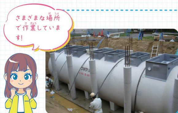
あら新しい浄化槽の設置工事や古くなった浄化槽の取りかえ工事を行っています。クレーンなどの大きな機械を使用するため、ケガをしないよう注意をしています。
