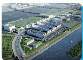
東京にある公設卸売市場「豊洲市場」の屋根と外壁を施工しました。
