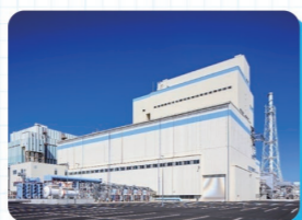
茨城県内の火力発電所施設の外壁工事も行いました。
