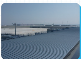
東京国際空港のターミナル施設では、屋根と外壁も施工しました。
