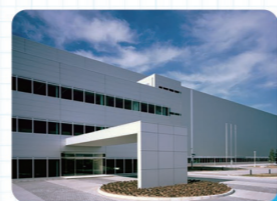
茨城県内にある工場大規模な建造物です。
