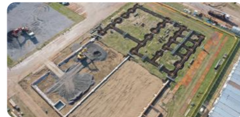
建設中の新工場 (ドローン撮影)
